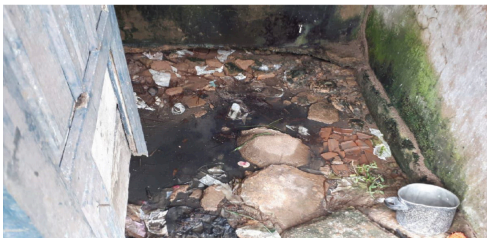
Figura 2: Parte interna del baño. Fotografía: DSEI/Divulgación - 2022.
