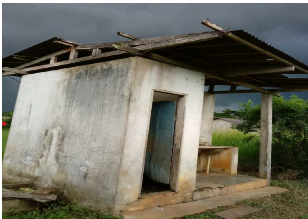
Figura 3: Parte externa del baño. Fotografía: DSEI/Divulgación - 2022
